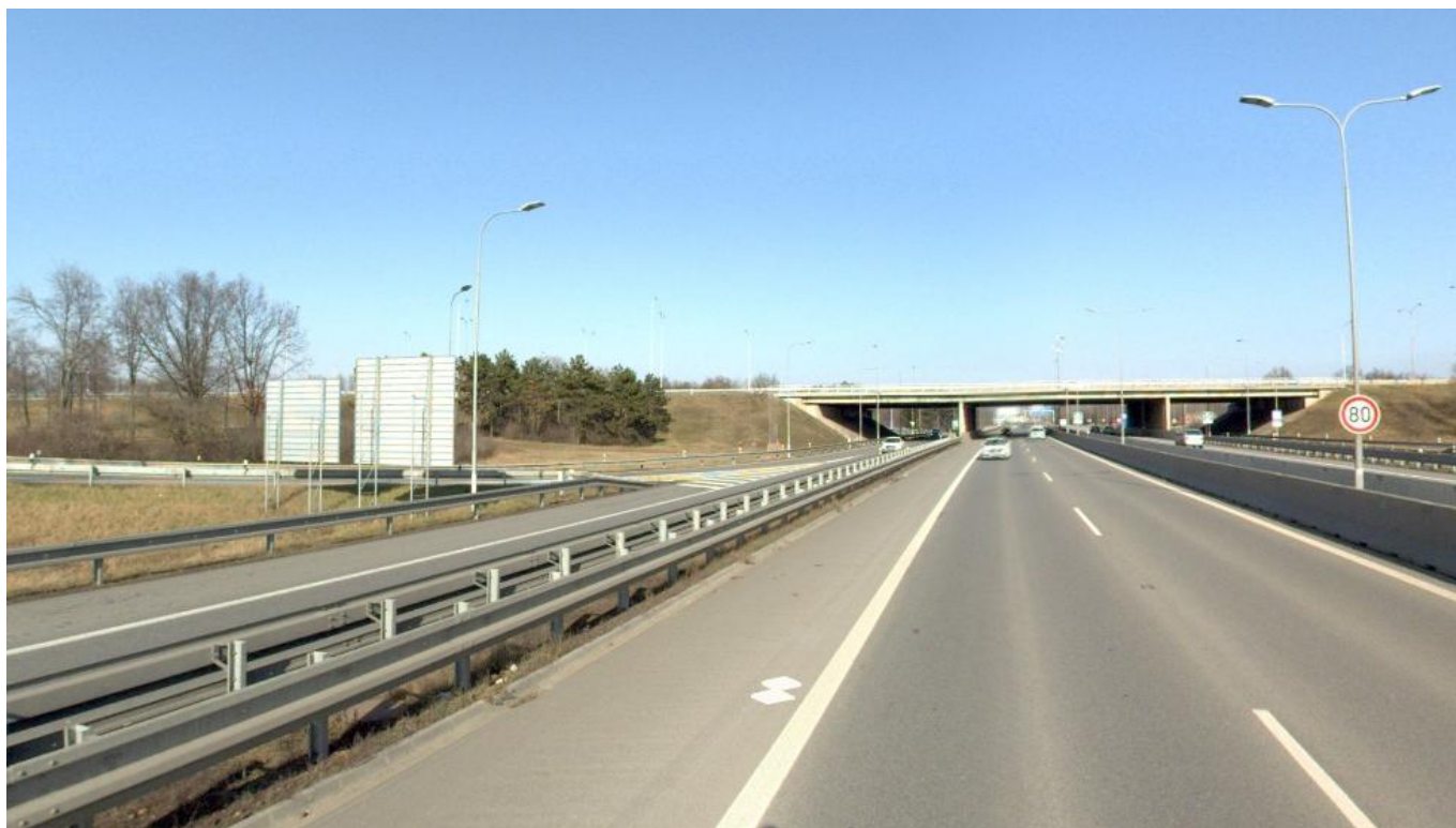
Ukázka provedené signalizace VLB na vozovce
